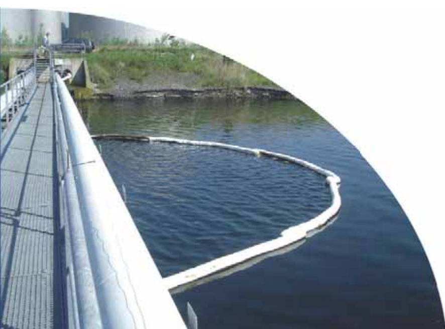
Useammat puomit muodostavat padon rajaamaan vuotoa
